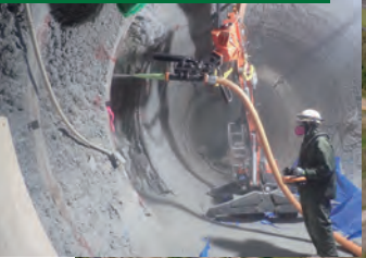
坑道へのセメント吹付け遠隔施工試験
