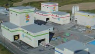
地下施設建設現場
